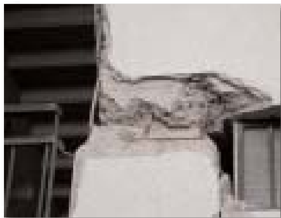
Figura 2.3.16: Edificio abitativo di recente costruzione a S. Venerina. E' stato rilevato uno spostamento del primo solaio al nodo trave -pilastro. Il piano di slittamento corrisponde alla ripresa del getto di calcestruzzo.
