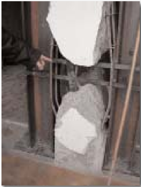
Figura 2.3.17: Opere in ferro per la messa in sicurezza di un pilastro crollato (S. G. Bosco).
