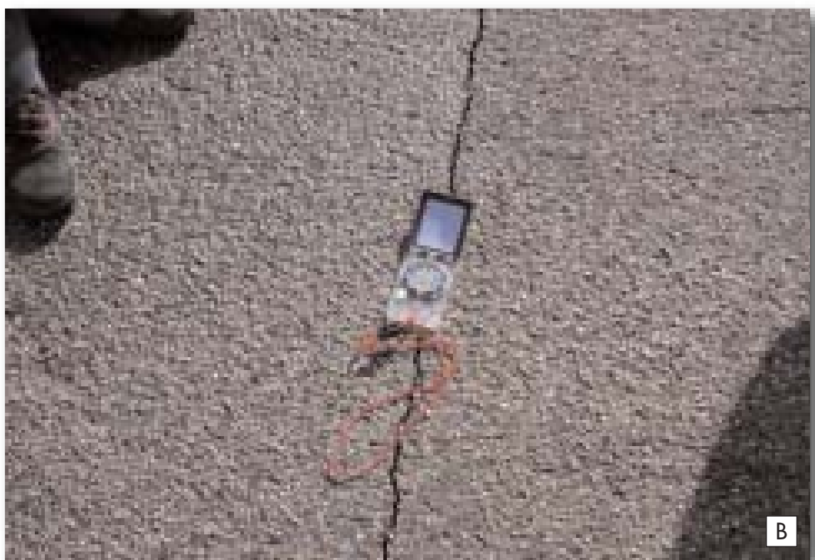
Figura 2.4.10: Due fratture cosismiche che hanno interessato la sede stradale a nord dell'abitato di San Giuliano di Puglia. A) frattura 12 in Tab. II, B) frattura 8 in Tab. II.
