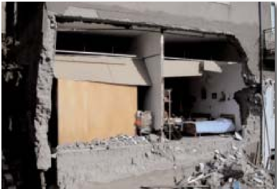
Figura 2.4.15: S. Giuliano di Puglia. Collasso di un muro esterno. Si nota l'apertura di un vano per l'accesso alla cantina in prossimità dello spigolo del fabbricato, che ha creato una zona di debolezza strutturale.
