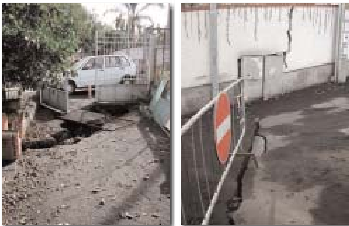
Figura 2.3.6: Fratturazione del manto stradale e nel terreno in località Scura.
