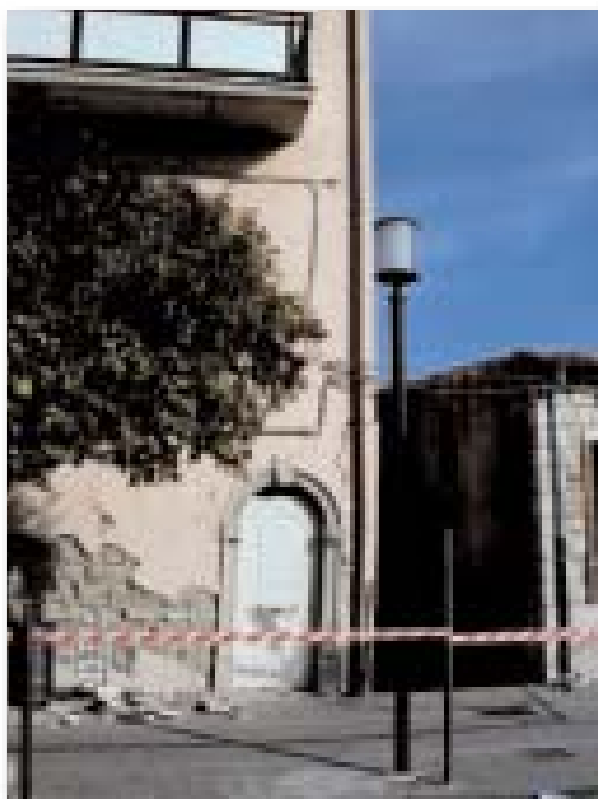
Figura 2.4.18: S.Giuliano di Puglia. La porta di ingresso adiacente allo spigolo del fabbricato ha creato una zona di debolezza strutturale.
