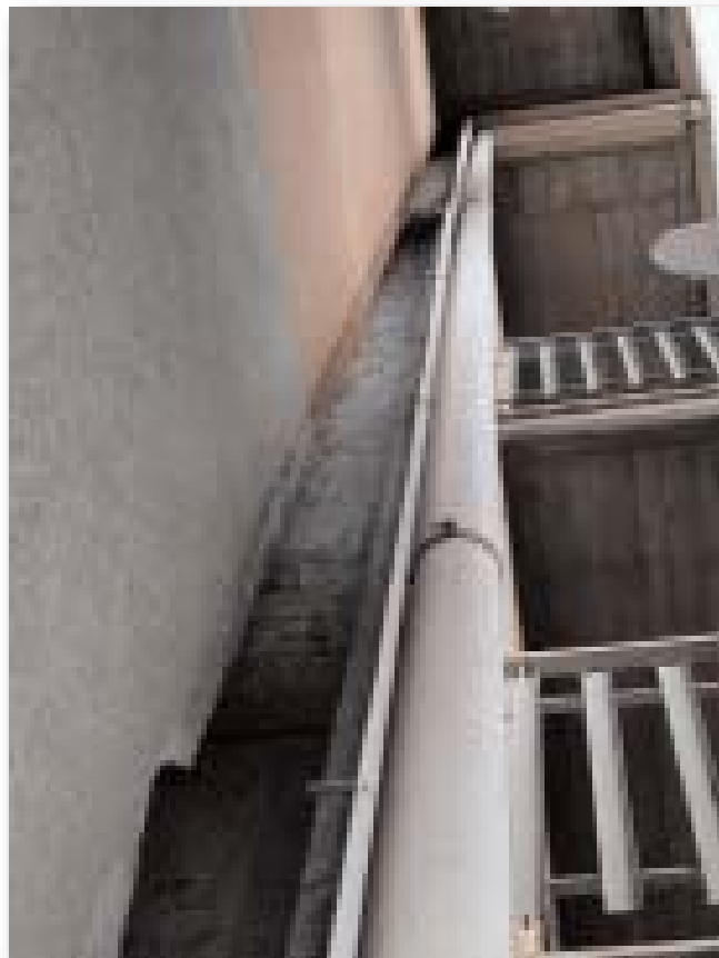
Figura 2.3.20: Dettaglio della foto precedente che evidenzia lo spostamento di un fabbricato abitativo nella zona del giunto, realizzato per adeguare le deformazioni dell'edificio a quelle del terreno.
