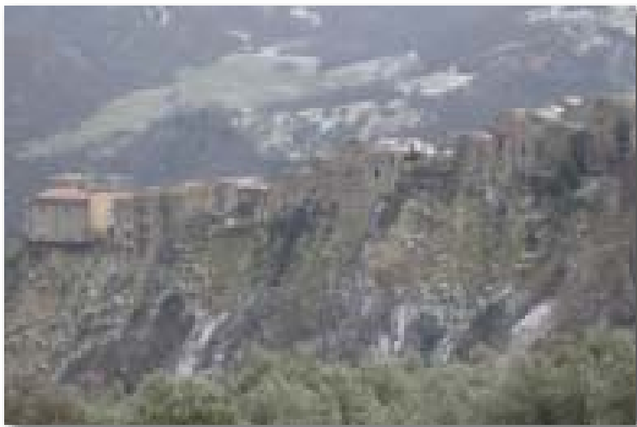
Figura 1.4.28: Versante in destra idrografica del Torrente Mordale. I fenomeni di arretramento del versante stanno scalzando le fondazioni di alcune abitazioni.
