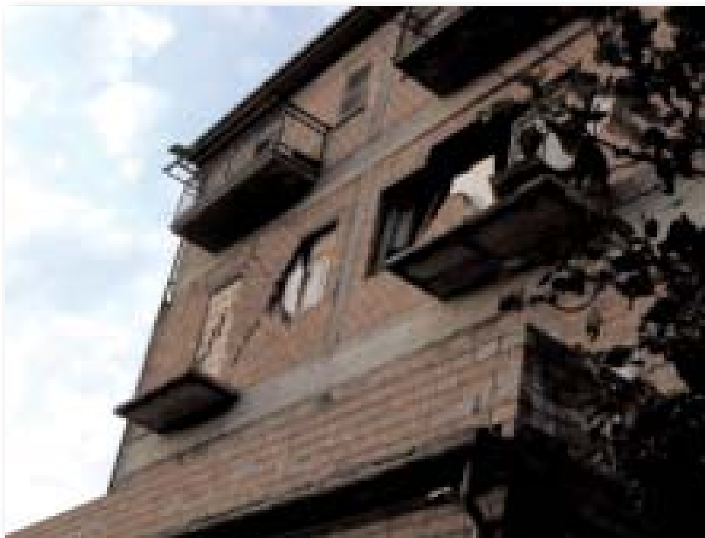
Figura 2.4.13: Bonefro. Esempio di struttura mista danneggiata nell'angolo. La struttura è a rischio di collasso totale
