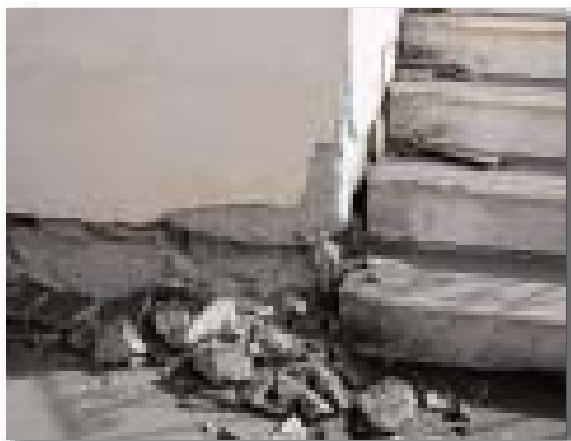
Figura 2.3.15: Plasticizzazione del nodo trave-pilastro (S. G. Bosco).
