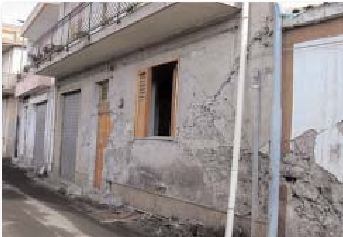
Figura 2.3.11: Lesioni incrociate da sollecitazione sismica in edificio in muratura di pietrame con ricorsi di mattoni (S. G. Bosco).
