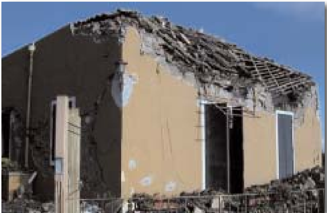
Figura 2.3.14: Crollo del tetto in un vecchio edificio in muratura di pietrame (S. G. Bosco); può essere osservata la mancanza del cordolo e la sostanziale tenuta delle catene.
