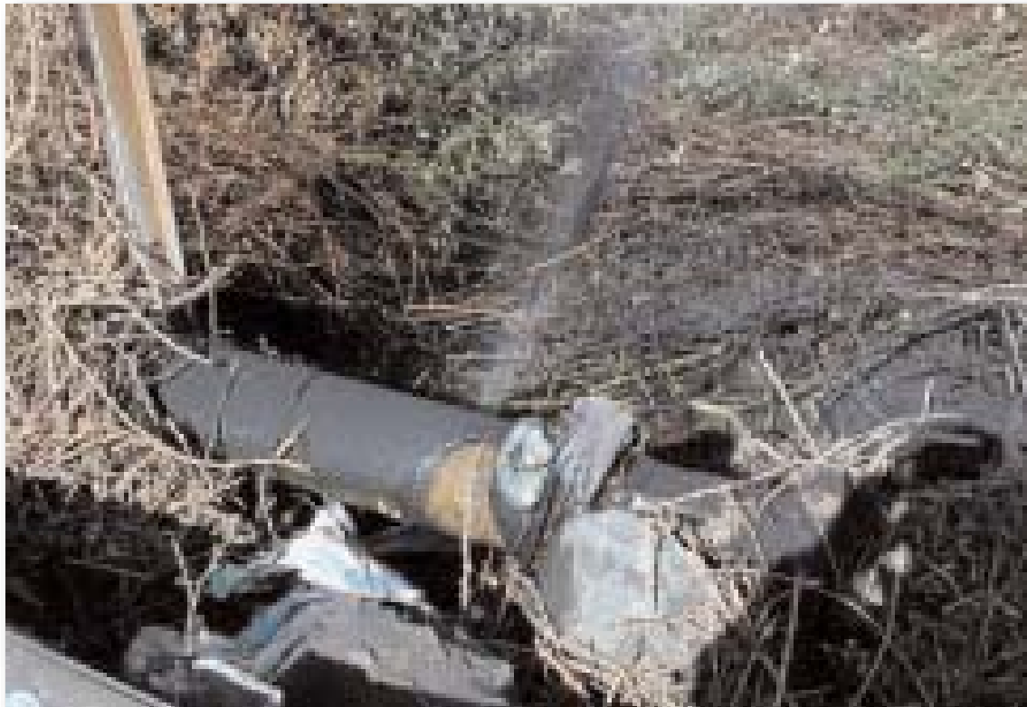
Figura 2.3.10: Rottura delle condutture idriche in corrispondenza del cavalcavia dell'autostrada posta tra Linera e Guardia.
