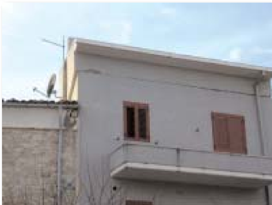
Figura 2.4.17: S.Giuliano di Puglia. Slittamento del solaio superiore dal fabbricato.
