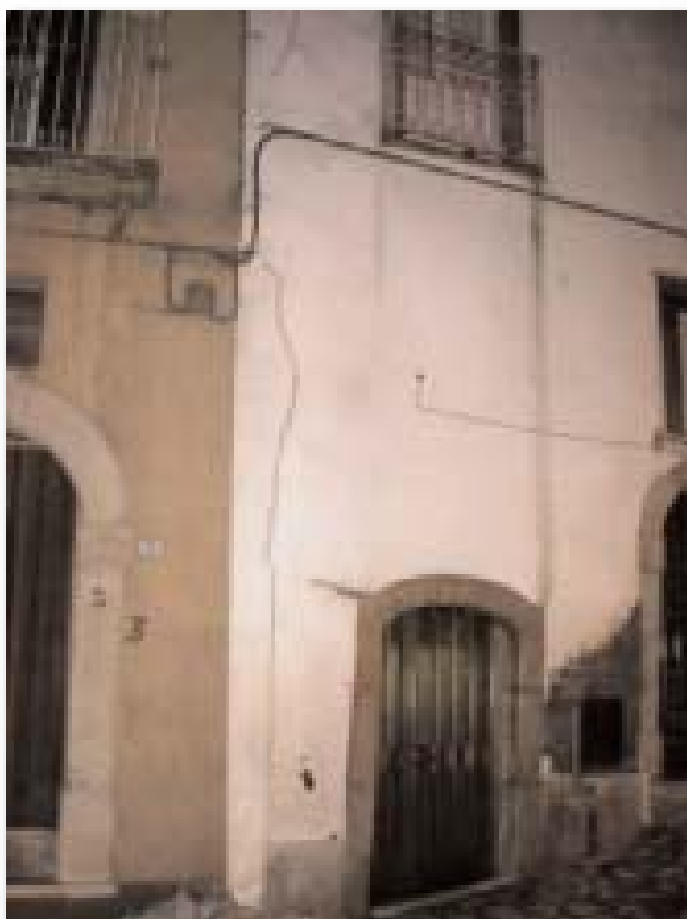
Figura 1.4.18: Quadro fessurativo in una delle abitazioni di Via Annunziata, oggetto dell'ordinanza di sgombero
