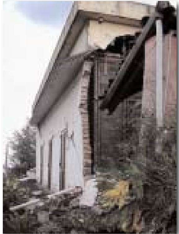
Figura 2.3.13: Struttura portante verticale realizzata con un unico corso di mattoni (S. Venerina).
