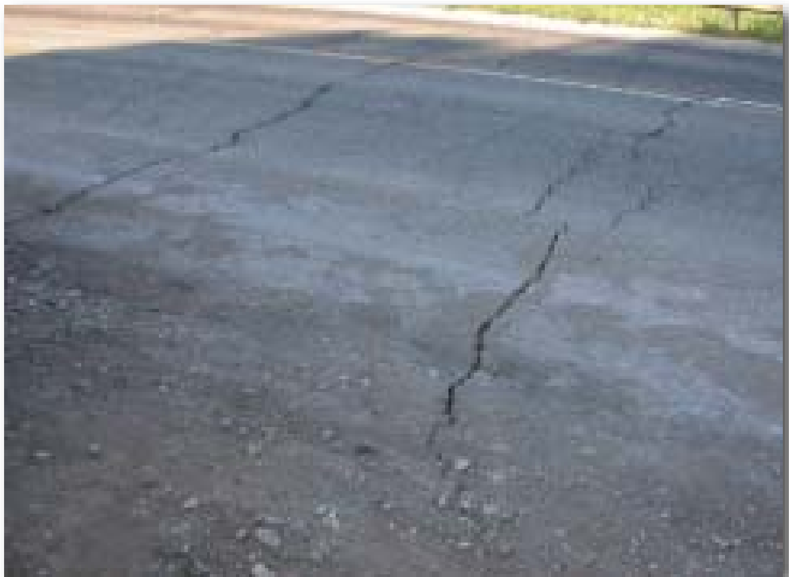
Figura 2.4.4: Fratture sul manto stradale al km 45 della SS 647 Bifernina, legate alla mobilizzazione di un corpo di frana preesistente.
