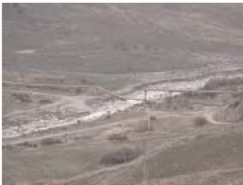
Figura 1.4.24: La piena del Torrente Rivo ha determinato il crollo di parte di un ponte della strada comunale
