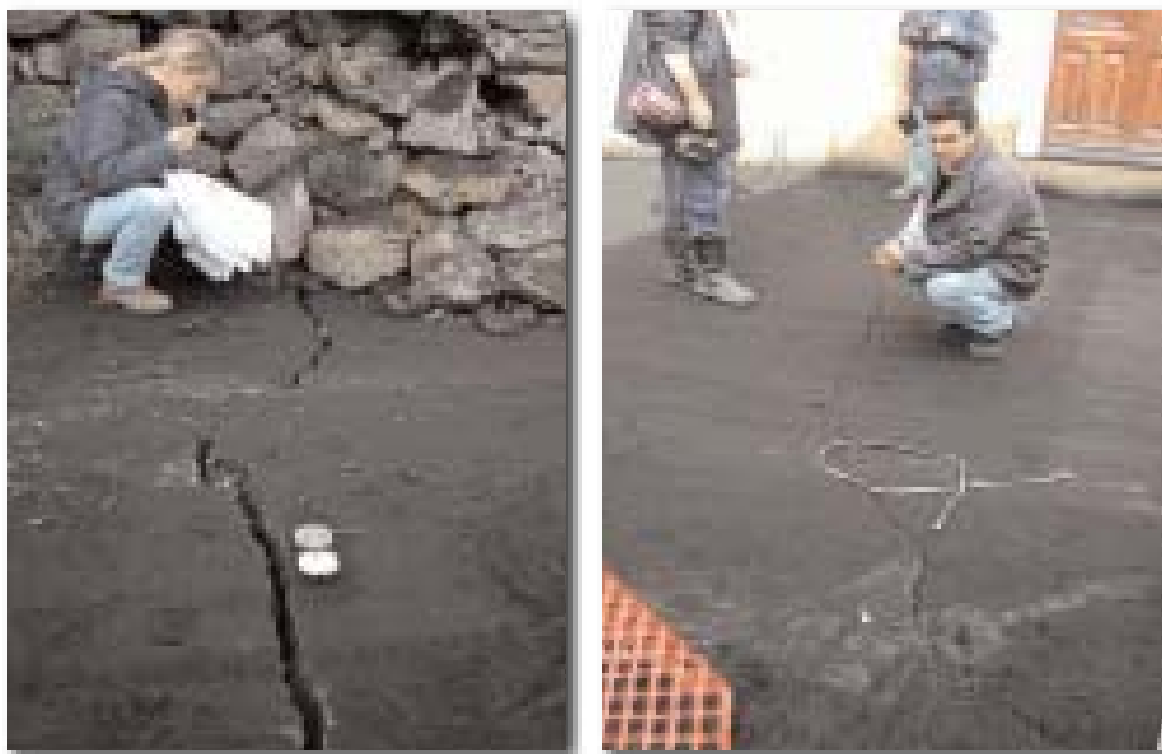
Figura 2.3.5: Fratturazione del manto stradale nel centro abitato di S. Venerina (a destra) e in località Dagala Canne (a sinistra).
