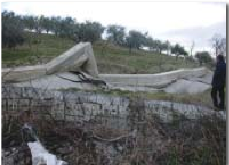
Figura 1.4.31: Deformazioni di un tratto di strada e di un cordolo in c.l.s., di recente sistemazione.
